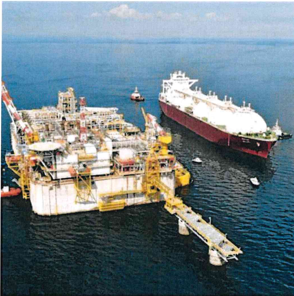
Un impianto di rigassificazione in mare
