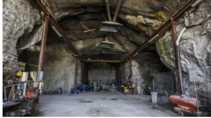
L'interno della Cava di Monte Tondo nei pressi di Casola Valsenio
