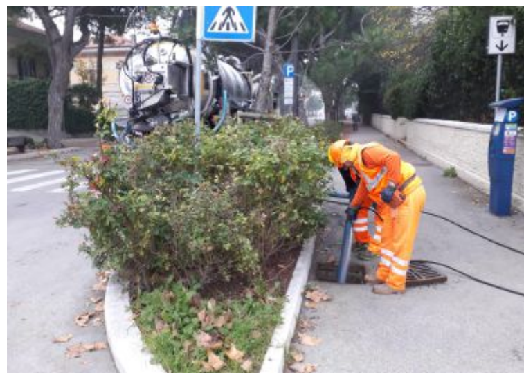
Un'operazione di pulizia delle caditoie FOTO DI REPERTORIO
